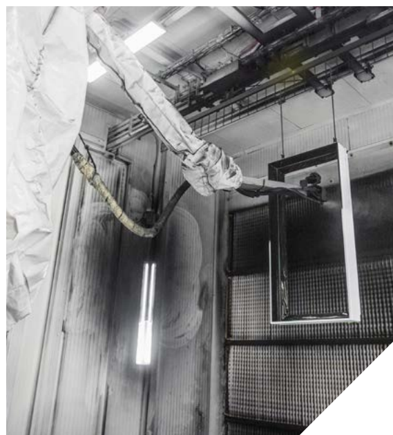
Ligne robotisée pour l'application de peinture
